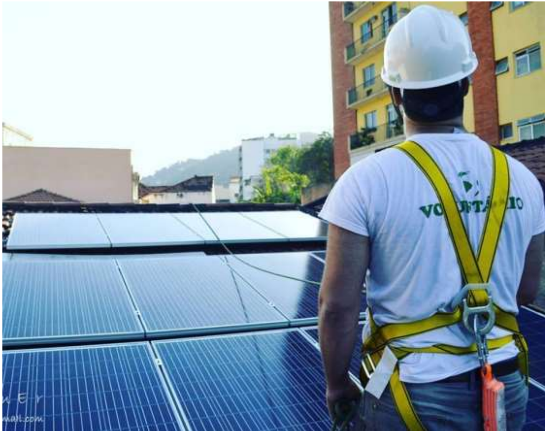
Volontari della organizzazione Ingegneri Senza Frontiere hanno donato e installato il sistema dei pannelli solari nella Casa di Accoglienza
