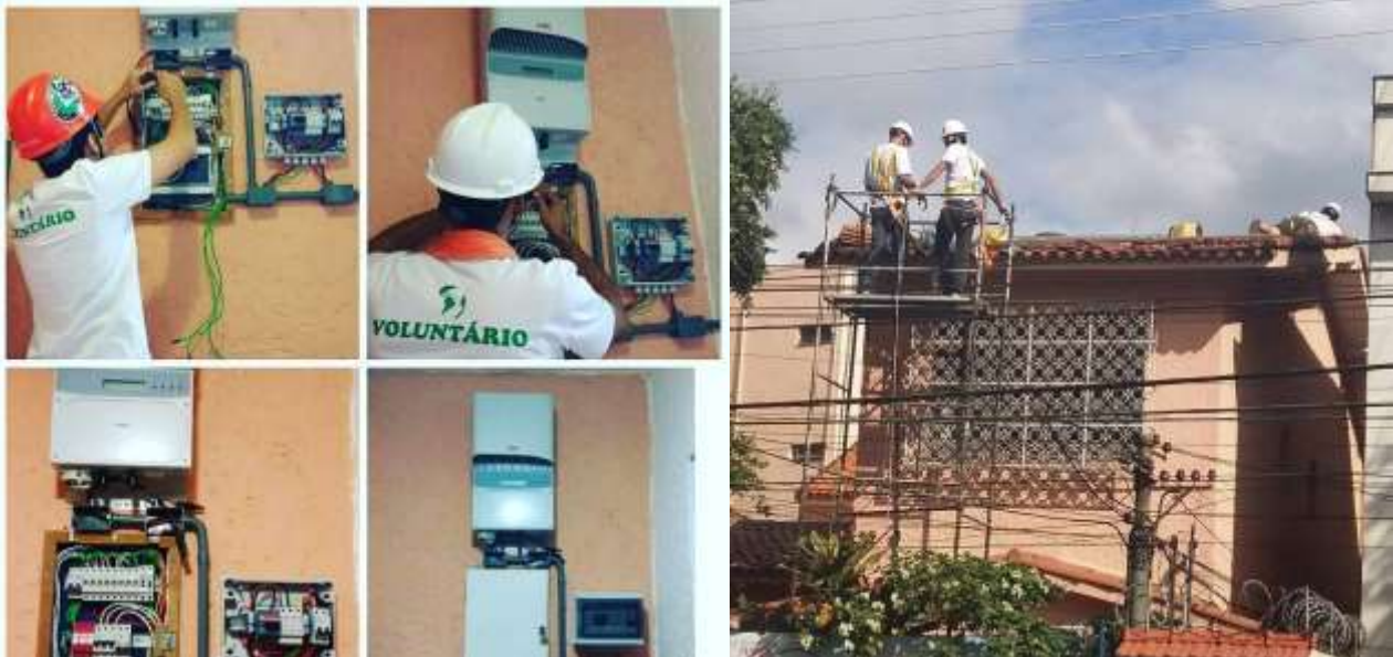
Volontari della organizzazione Ingegneri Senza Frontiere hanno donato e installato il sistema dei pannelli solari nella Casa di Accoglienza
